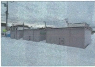
3連の右側が増設連町防災倉庫
