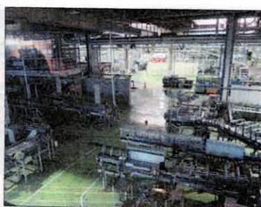
千歳麒麟ビール工場の製造棟
